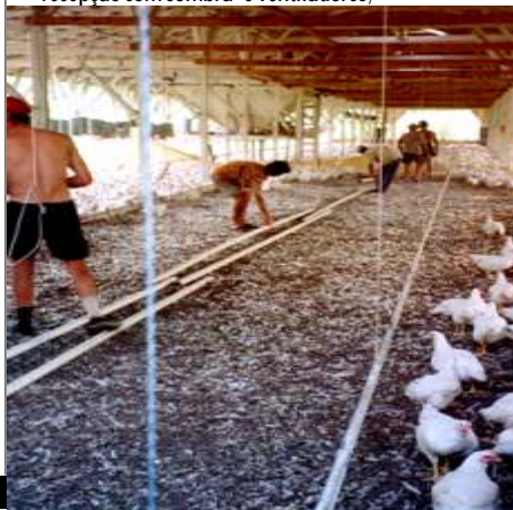
9 lação de tubos de PVC
